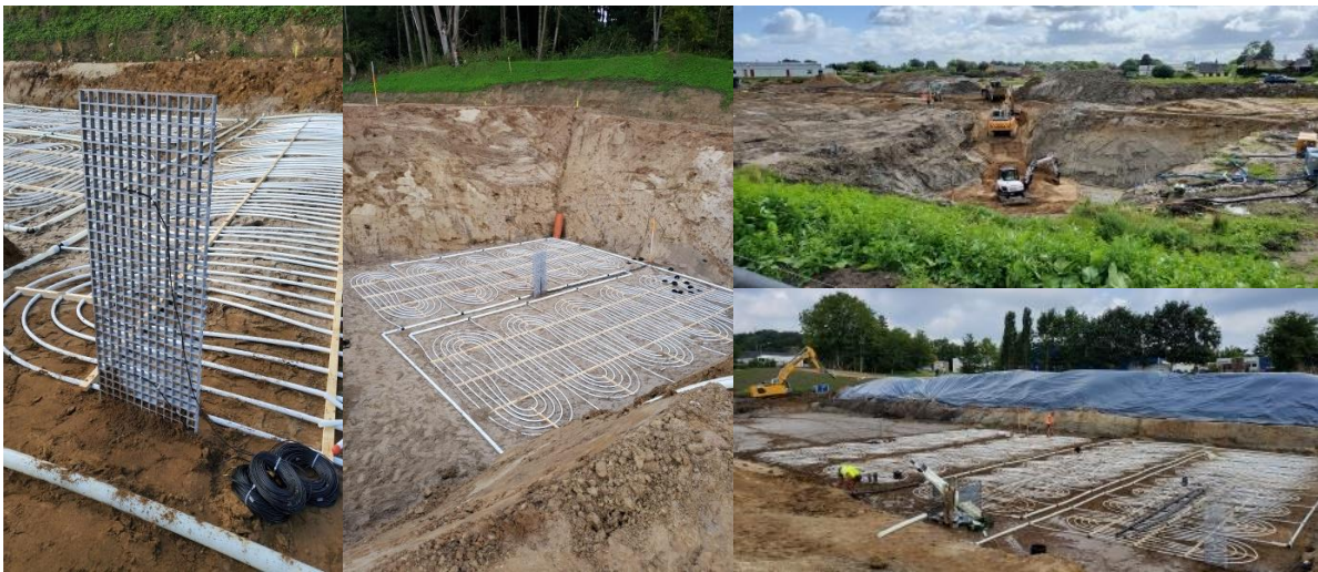
Abbildung 29: Gitter mit angebrachten Sensoren in der westlichen GKA unter der Freifläche (links), Vierte Kollektorebene EES unter Freifläche (Mitte), Aushub EES unter Regenrückhaltebecken (oben rechts) und GKA unter Regenrückhaltebecken (unten rechts)
