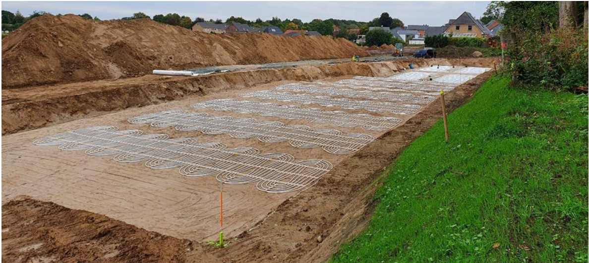
Abbildung 21: Einbau Großkollektoranlage unterhalb der Freifläche
