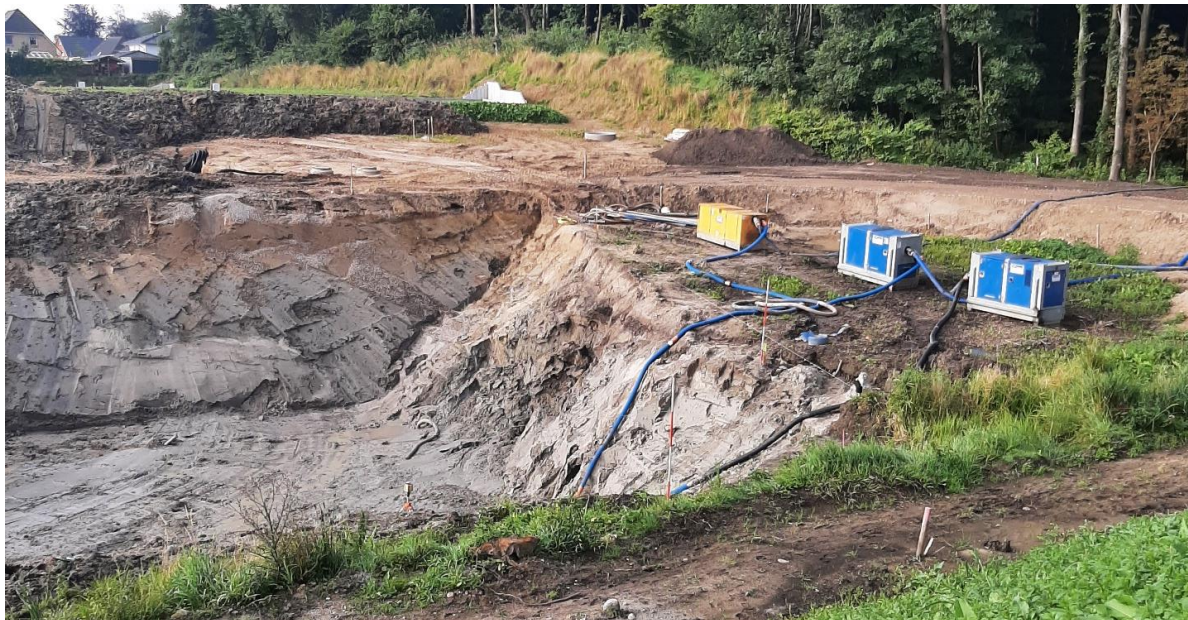
Abbildung 22: Geschlossene Wasserhaltung beim Einbau des Erdispeichers unterhalb des Regenrückhaltebeckens
